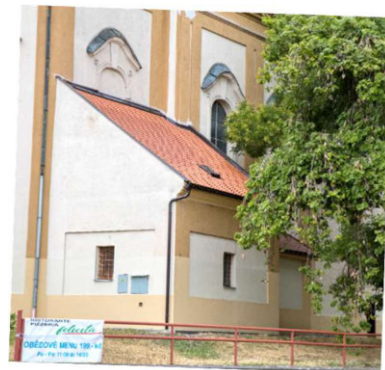
Nové části krovu a krytina.
